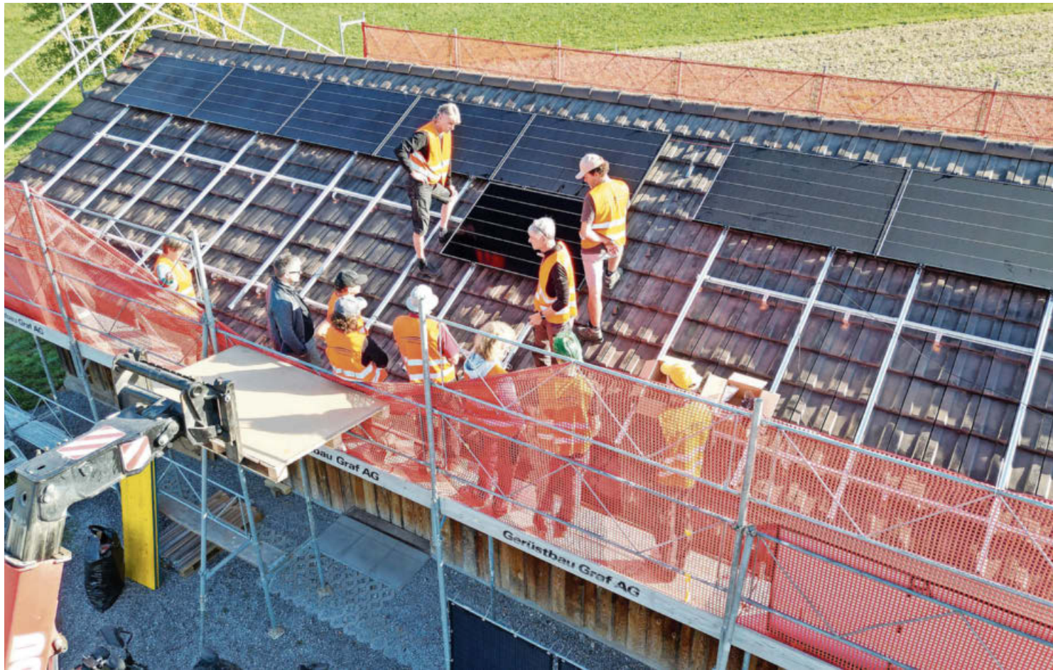
Zahlreiche Freiwillige arbeiten Hand in Hand für die dorfeigene Solaranlage auf dem Dach des Schützenhauses.
