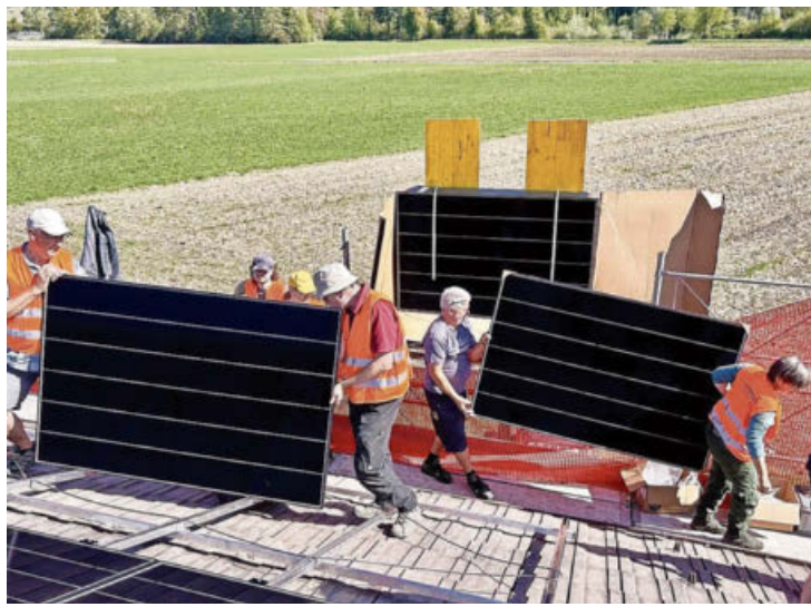
Insgesamt 60 Panele werden auf dem Dach befestigt.
