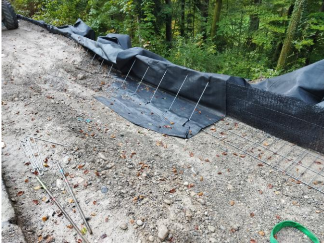
Foto: Böschungsstabilisierungssystem BaFix, Etappe 2021 «Sanierung Manzenhubstrasse»
