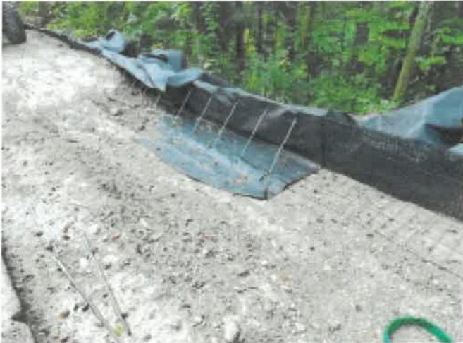
Foto: Böschungsstabilisierungssystem BaFix, Etappe 2021, Sanierung Manzenhubstrasse
