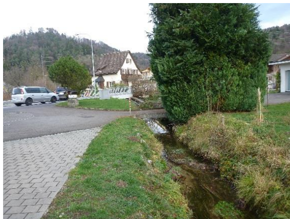
Brücke vor km 0.11
