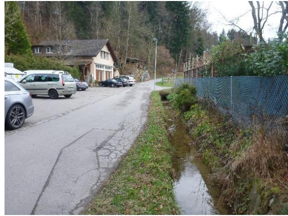
Offenes Gerinne bei km 0.38 (Blick gegen Fließrichtung)
