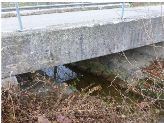
Brücke bei km 0.0
