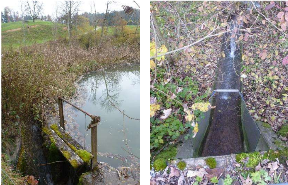
Abbildung 5: Bodenweiher, links: Blick auf den Hauptweiher mit Durchlass und Holzschieber, rechts: Schussrinne unterhalb Damms
