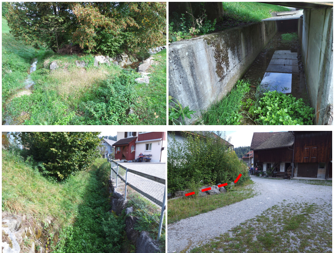
Abbildung 34: Der Quellbach fliesst links durch die Kernzone (oben links), der Abschnitt Que-03 verläuft eingedolt unter einer Fussgängerbrücke und der Katzenbachstrasse (oben rechts), neben einem Parkplatz und Häusern verläuft Abschnitt Que-02 (unten links), der eingedolte Abschnitt Que-01 verläuft unter der Zufahrt zum Innenhof (rote Linie, unten rechts)
