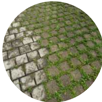
Verbundsteine mit offenen Fugen
