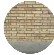
Sockel und Mauer Südwestfassade
