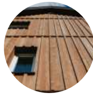
Deckleistenschalung mit Säheroh Holz Referenzbild Nordost
