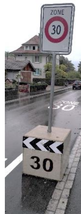
Abbildung 5: Eingangstor mit Betonwürfel
