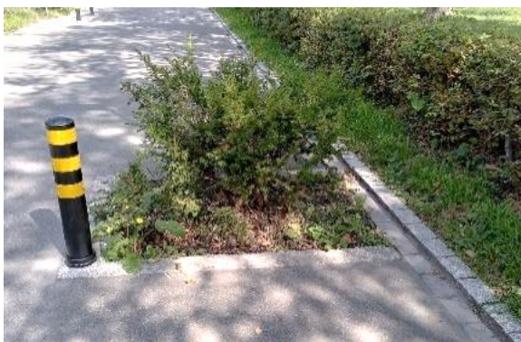
Abbildung 6: Beispiel einer Rabatte in der Fahrbahn
