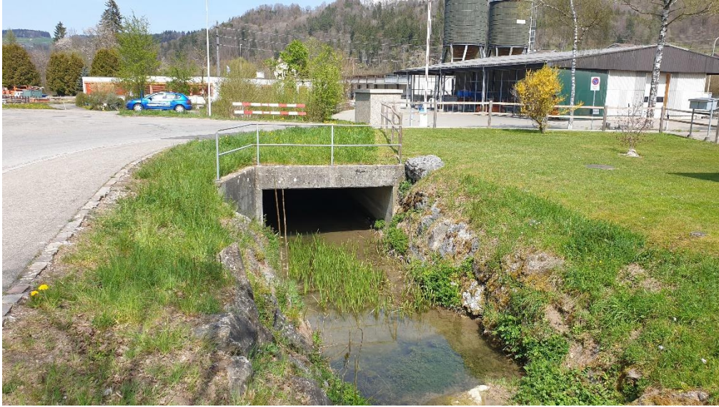
Abbildung 21 Durchlass Mülibach, Blickrichtung von Püntstrasse
