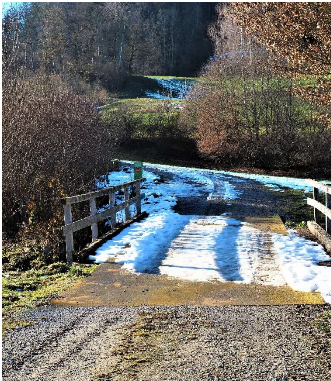
Abbildung 23: Brücke über den Lochbach
