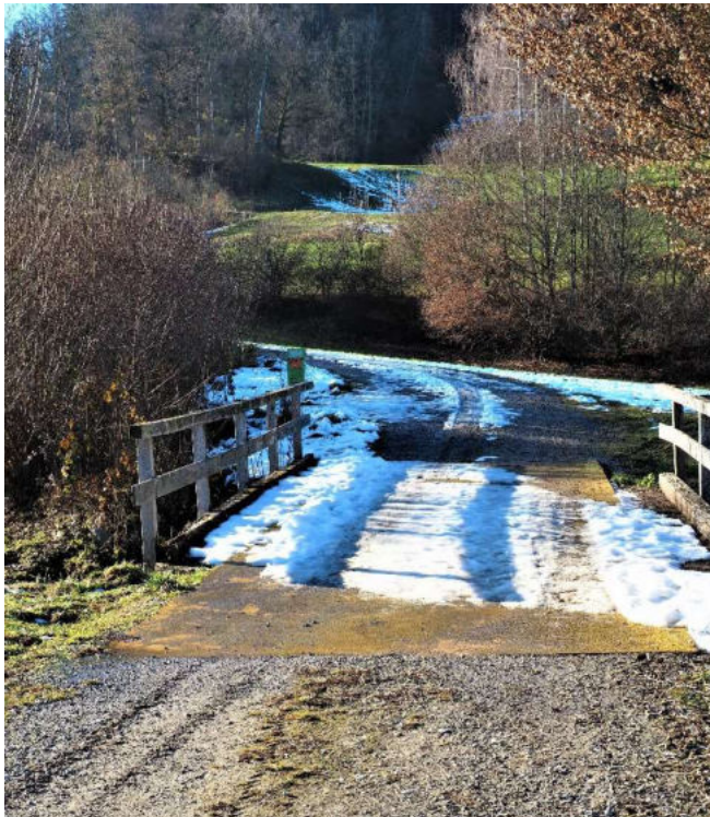
Abbildung 23: Brücke über den Lochbach
