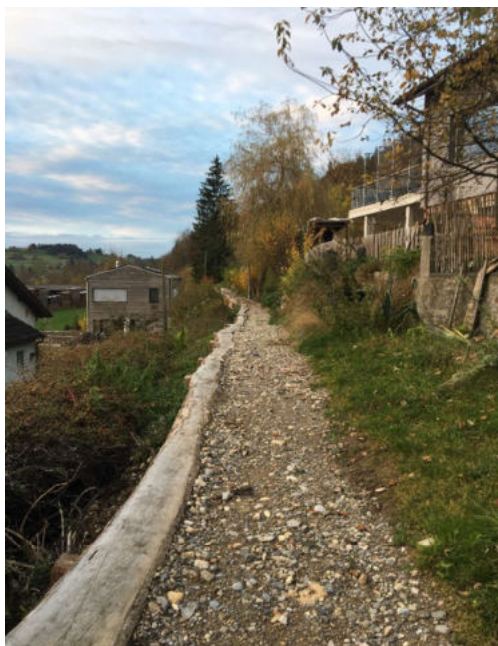
Abbildung 5: Fussweg im Jakobsbrunnen
